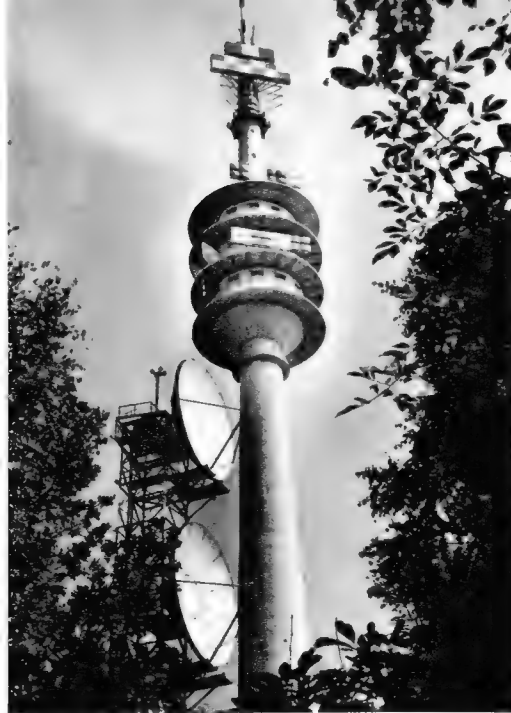
Der neue Fernmeldeturm auf dem Schäferberg in Berlin-Wannsee ist mit 212 m das höchste Bauwerk Berlins. Links die seit 1959 im Betrieb befindlichen Parabolspiegel (siehe auch unser Titelbild). Aufnahmen: Ernst Schwahn
